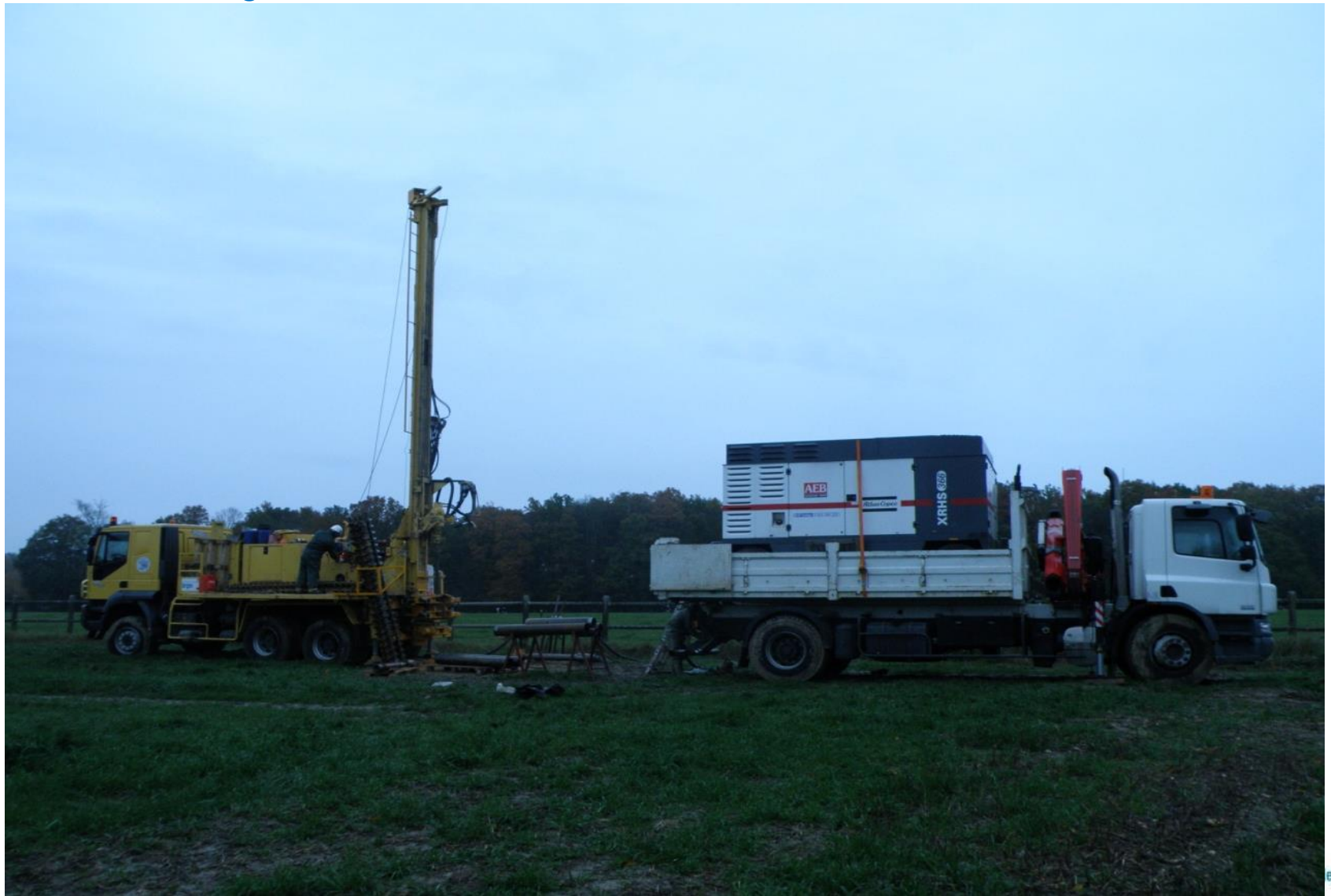
Location du compresseur 20 bar
