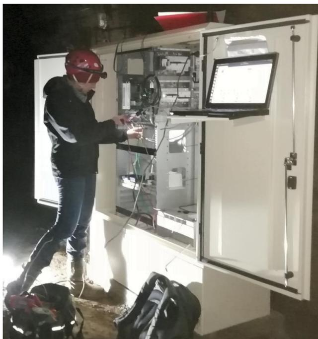
Figure 189 : Visite de maintenance par l'EOST de la station de Neufchef (Moselle), installée en 2019 dans un couloir de mine selon les standards définis par la DT (armoire contrôle/commande dans une baie outdoor)
