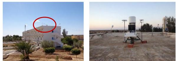
Figure 52 : Vue du bâtiment de l'IRA et vue des collecteurs de dépôt de type frisbee et Caraga sur la terrasse
