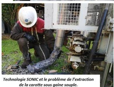
Technologie SONIC et le problème de l'extraction de la carotte sous gaine souple.
