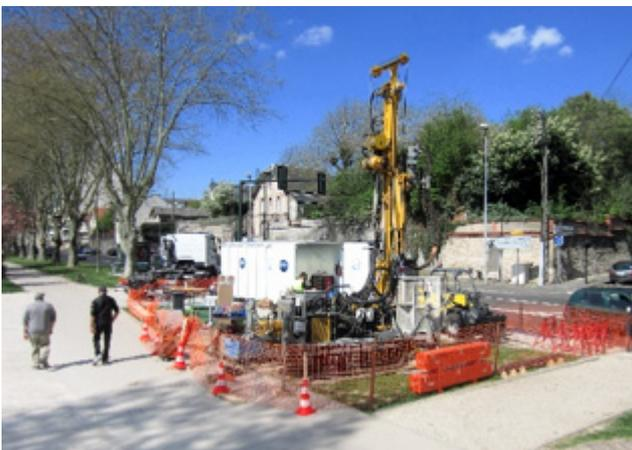
Figure 295 : Sondage dans la chambre à sable (collecteur d'égouts) à Orléans
