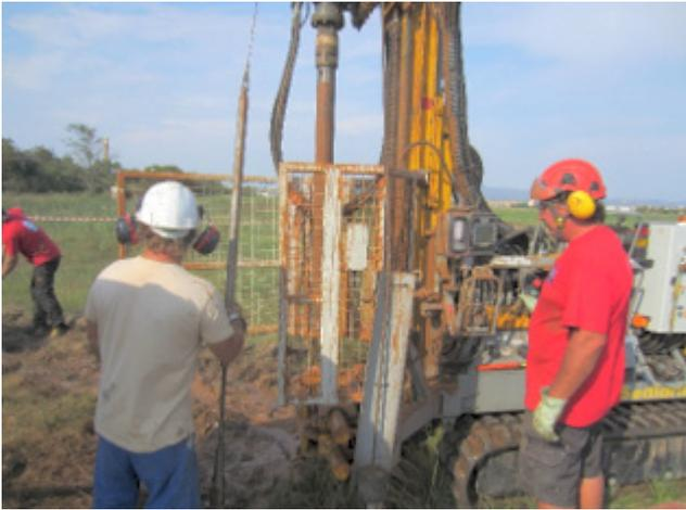
Figure 294 : Sondage au carottier à câble à Fréjus
