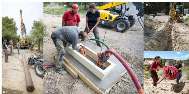
Figure 281 : Site CLAF – Gruissan - massif de la Clappe : a- Tube métal pour chemiser le forage ; b- Mise en place de la hausse de la future baie outdoor sur la dalle fraîchement coulée ; c- Réalisation d'une tranchée entre le site et le PDL ; d- Mise en place des fourreaux pour le passage des câbles (photos OMP)
