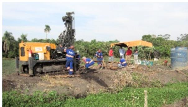
Figure 298 : Installation de la sondeuse rotative
