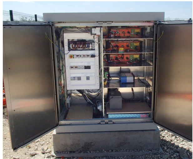
Figure 140 : Armoire électrique / instrumentale
