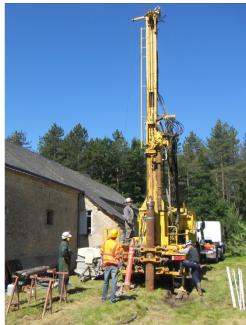
Figure 141 : Forage à Chambon la Forêt
