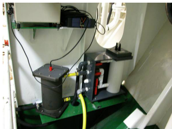
Capteur pCO 2 Carioca (à gauche) installé en série avec un TSG (à droite) sur le MN Colibri
