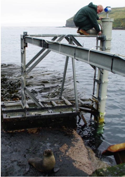
Radars marégraphiques dans son puits de tranquillisation
