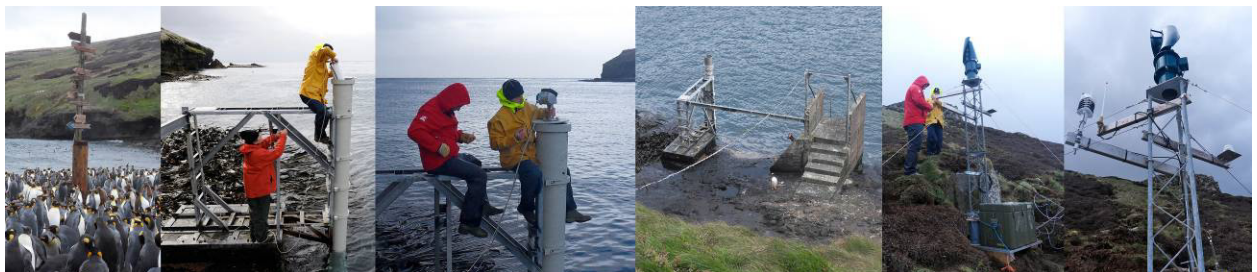
Installation de la station marégraphique de Crozet en novembre 2009 : puits marégraphique côtier, radar, station d'acquisition et météo, éolienne.
