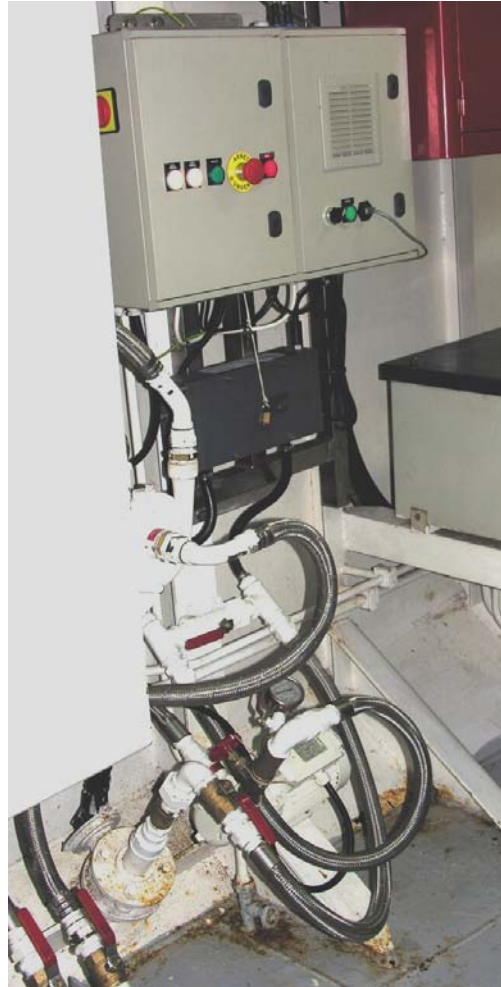
Thermosalinomètre installé dans le TETHYS II
